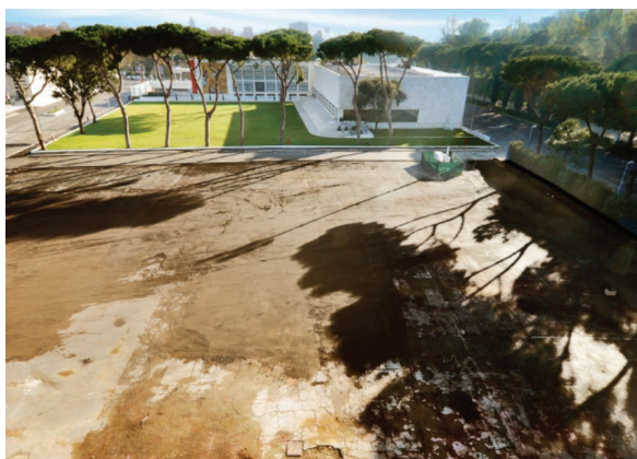
FIGURA 60 - REALIZZAZIONE DI 3 NUOVI CAMPI DI ALLENAMENTO
